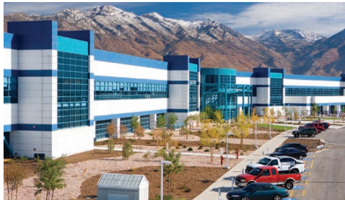
IM Flash Technologies Lehi, Utah Custom air handlers
